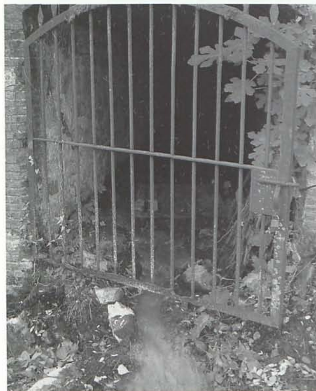
Fig. 1. Desagüe de las minas de F-Pb-Zn de Osor (Gerona) mediante una galería de varios kms de longitud
