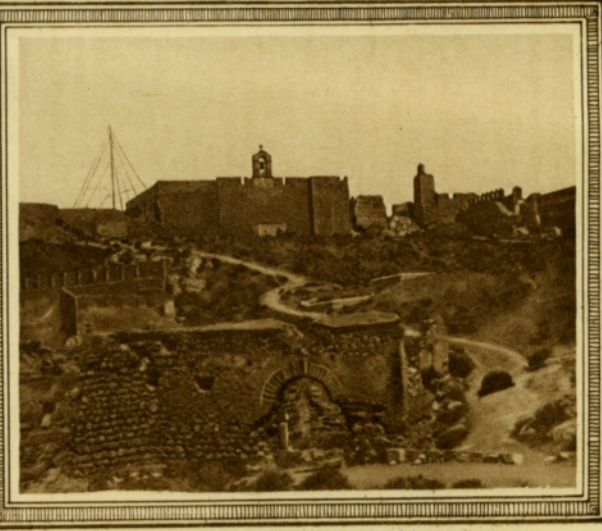
Torreones y Torre de la Vela en la Alcazaba.
