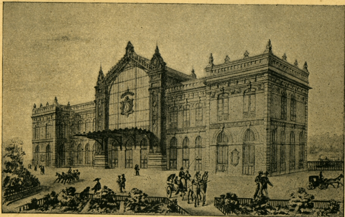
Estación del Ferrocarril de Almería a Linares
