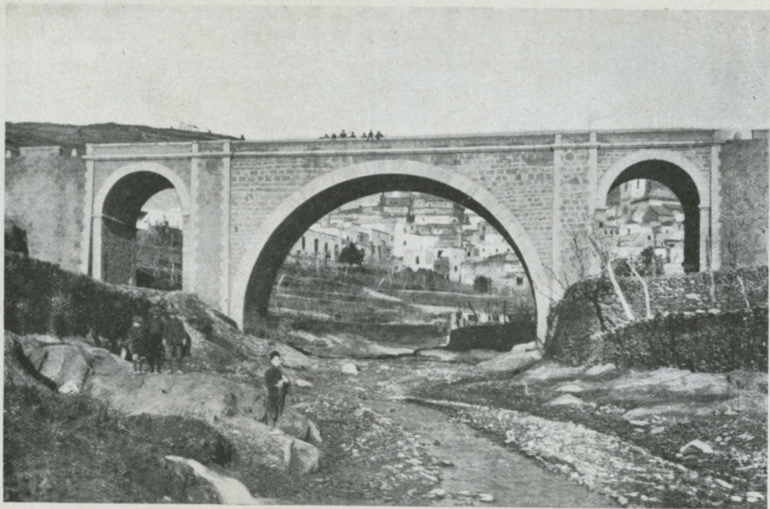
Sobre una rambla que vierte al río Almería, se tiende el puente por donde pasa la carretera de Tabernas.
