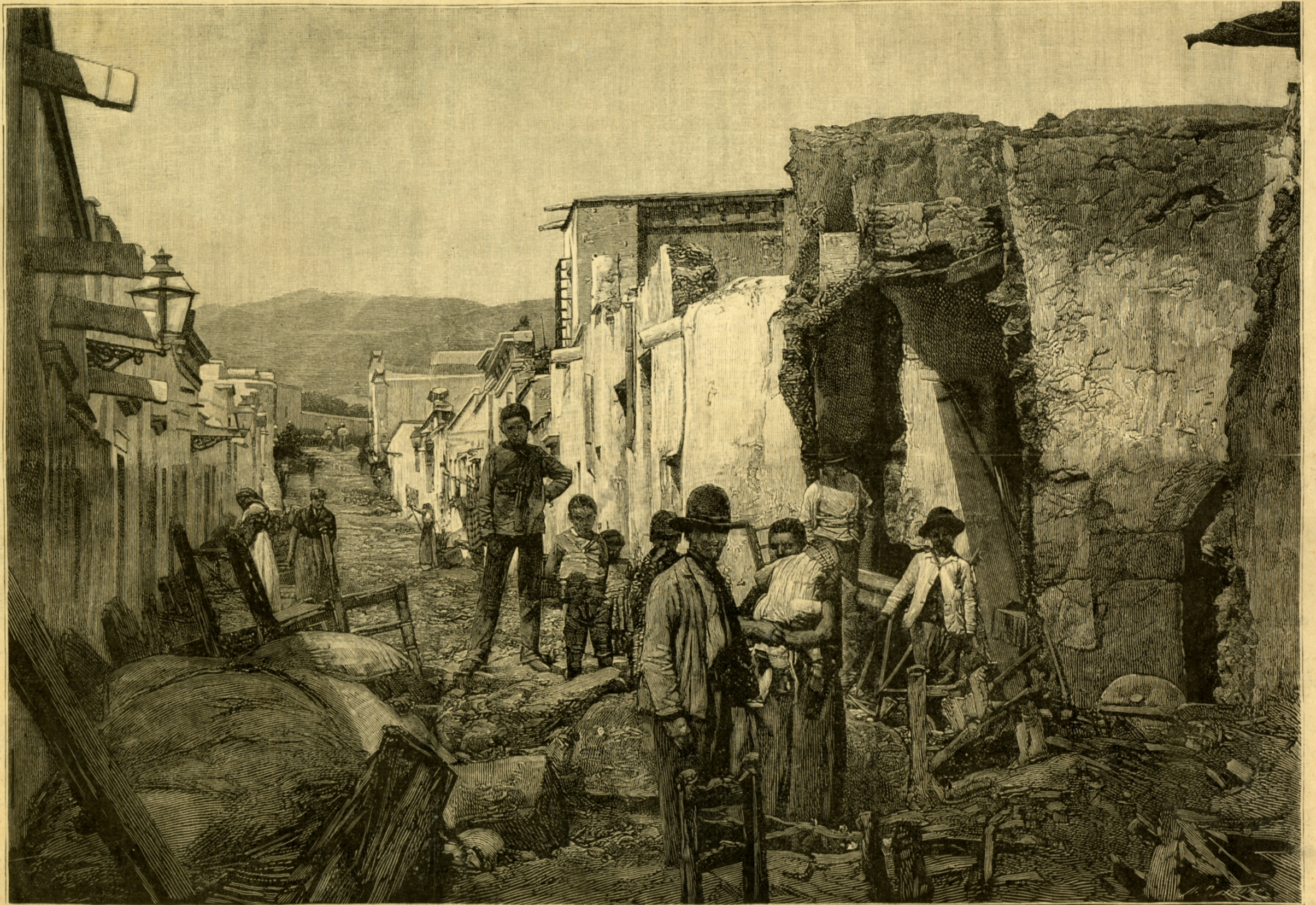
ASPECTO DE LA CALLE DEL GRAN CAPITAN, DESPUES DE LA AVENIDA.
