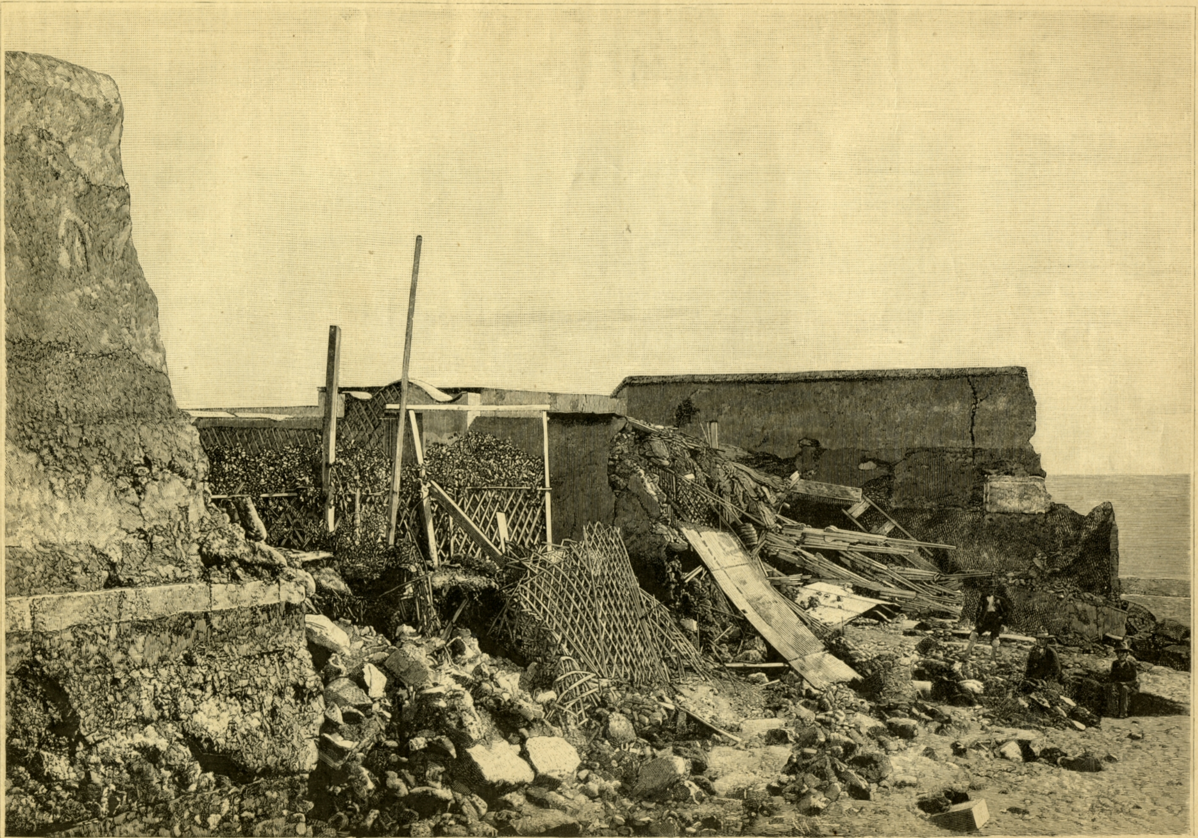
DESTROZOS PRODUCIDOS POR LAS AGUAS, EN LA PARTE DE PONIENTE DE LA FÁBRICA DEL GAS.
