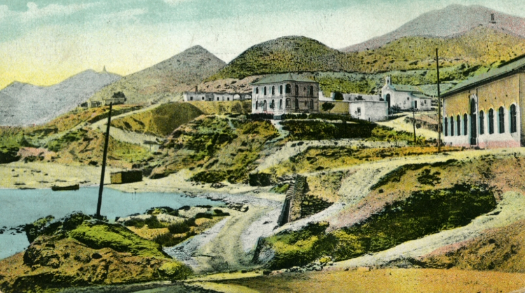
Instalaciones de la S. Argentifera - Villaricos.
