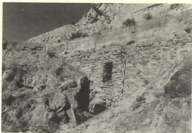
Lámina 1.—Alcantarilla en la conducción.
