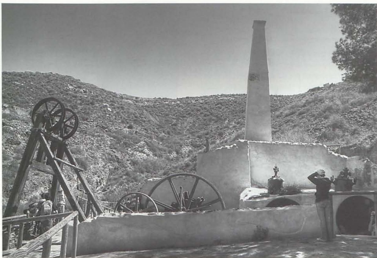
5. Los restos de la antigua casa de máquinas y la chimenea han sido remozados y el suelo del entorno se ha afirmado mediante un empedrado que ha tenido en la pizarra de Almagrera su principal materia prima. (Foto de Federico Moldenhauer)
