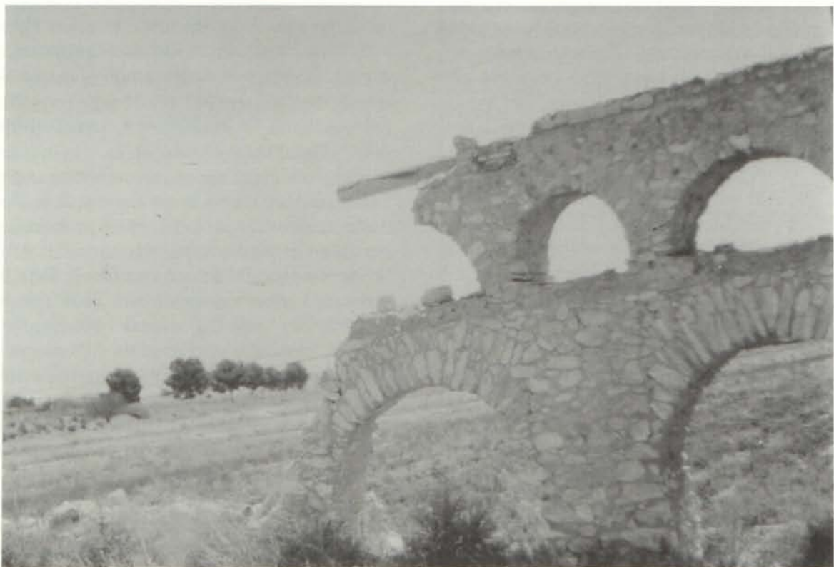
Acueducto del Real de Antas, en el punto en que la pala destructora se quedó.
