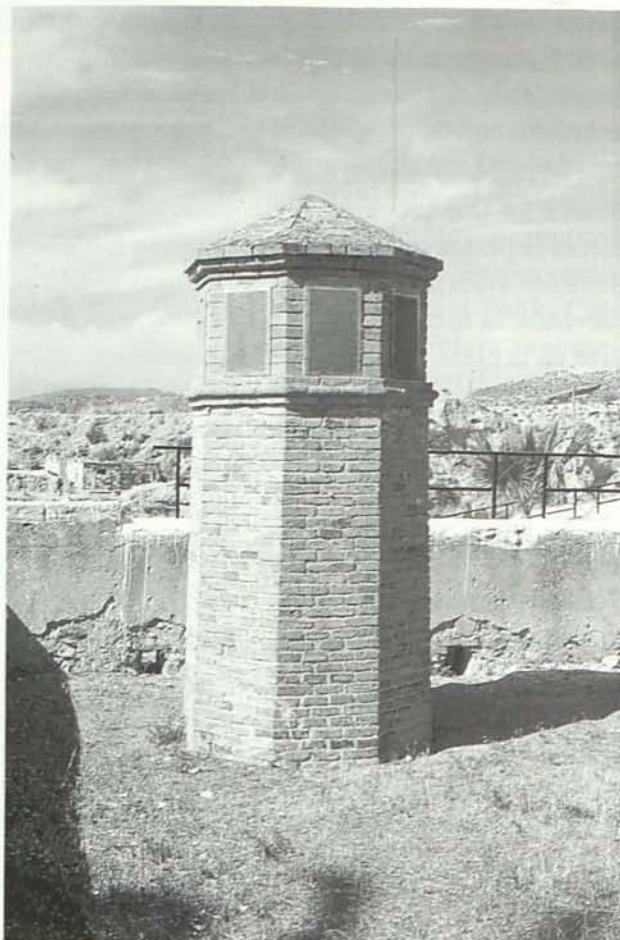
7. Respiradero-lumbrera del Depósito del agua. Sobre la cubierta se conservan perfectamente seis de estas estructuras construidas en ladrillo (Foto del autor).
