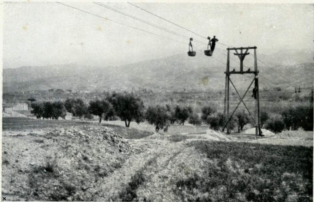
Desde la mina de hierro «Cuevas Negras» a la estación del ferrocarril, se halla tendido el cable aéreo para la conducción del mineral en la forma que representa el adjunto grabado.
