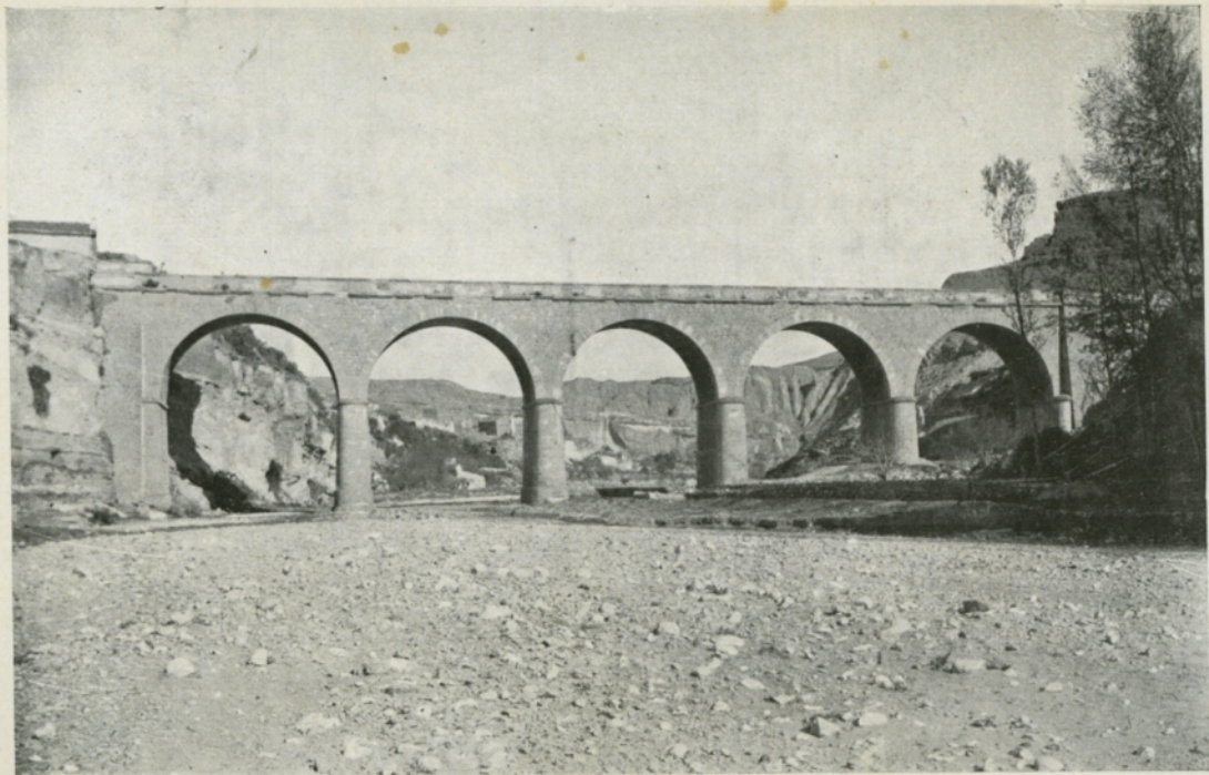
Sólida construcción de sillería, que cruza el profundo surco formado por el río en sus imponentes avenidas.
