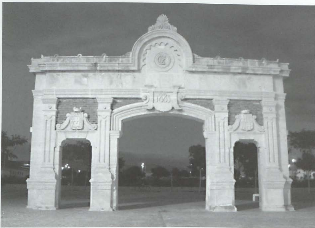
Puerta de "El Ingenio", fábrica reconvertida en prisión durante la Guerra Civil. Aquí sufrió su último día Rafael.
