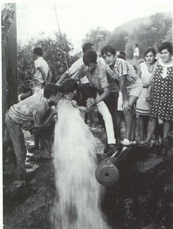
Captación de agua subterránea año 1969 al borde de la Sierra.
