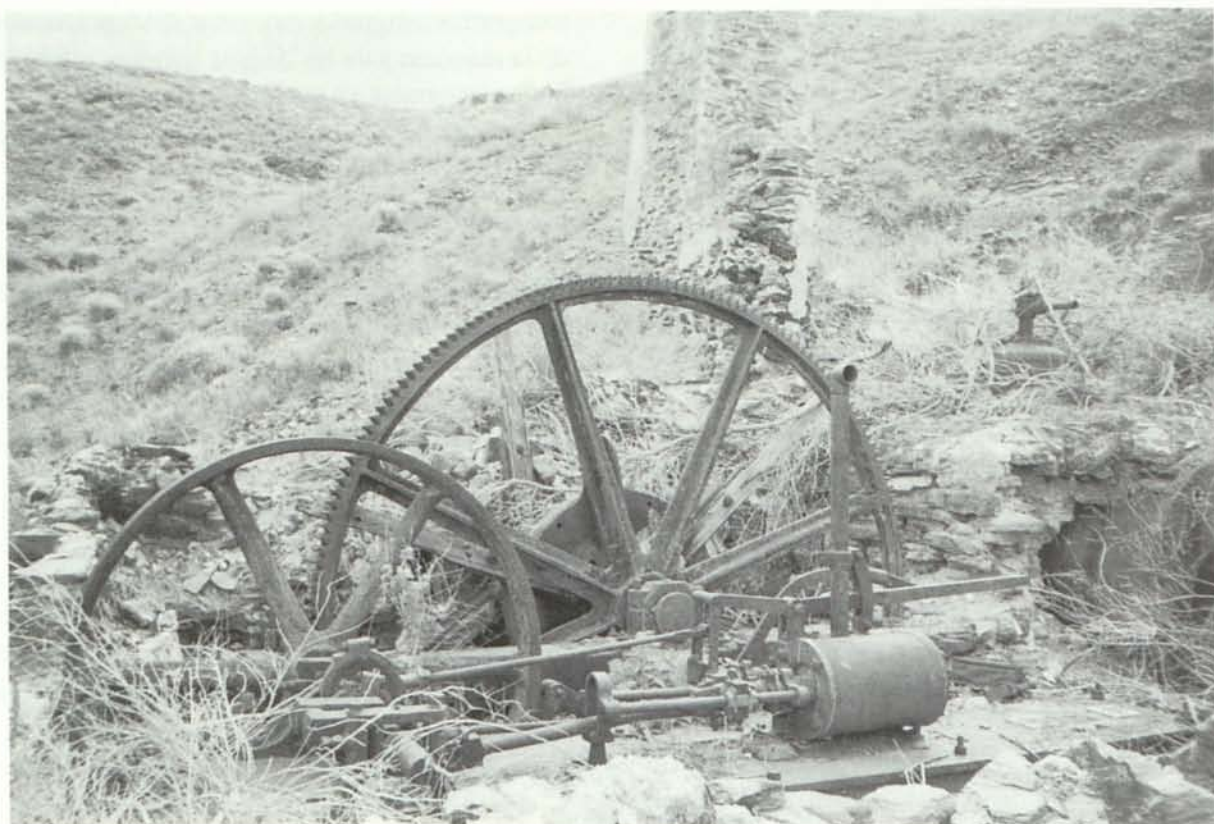
4. Vista lateral de la máquina de vapor en la que puede observarse el excepcional estado de conservación de todos los elementos mecánicos. A la derecha de la misma aparece una de las dos calderas que componen el ingenio, y sobre la misma una válvula reguladora de presión.
