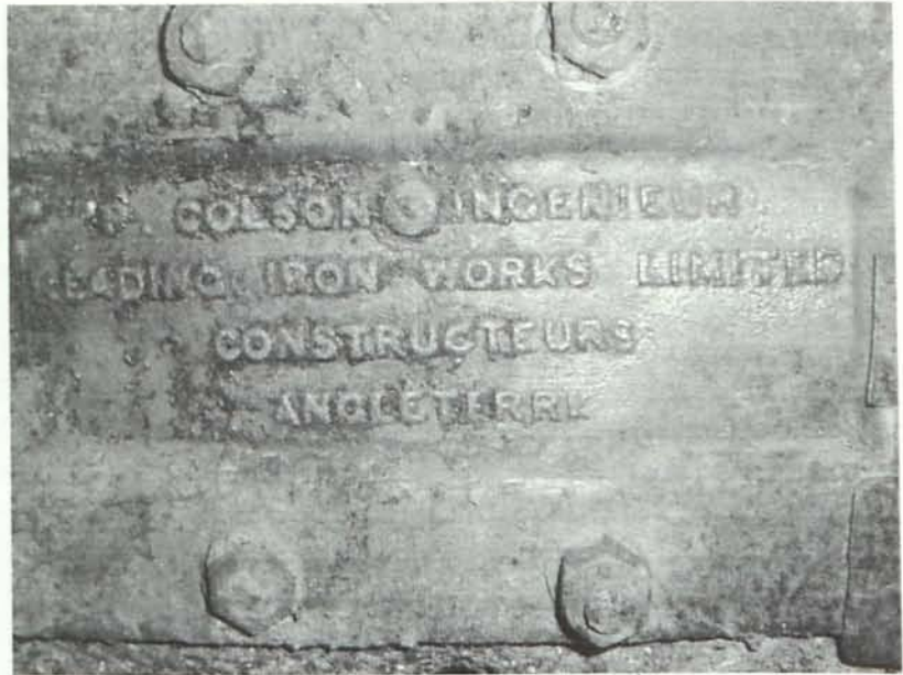
3. Placa del fabricante ( Reading Iron Works Limited ) y del constructor ( P. Colson ).
