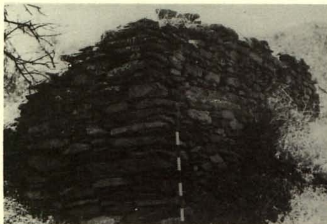
FOTO 2. Restos del ángulo norte de la torre rectangular de los Casarazos en el barranco de la Torrecilla (despoblado de Benalguaciles). El aparejo de lasjas de esquisto y de mortero de tierra es característico de todas las construcciones medievales de la zona.
