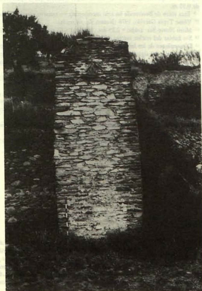
FOTO 2. Restos del ángulo norte de la torre rectangular de los Casarazos en el barranco de la Torrecilla (despoblado de Benalguaciles). El aparejo de lasjas de esquisto y de mortero de tierra es característico de todas las construcciones medievales de la zona.
