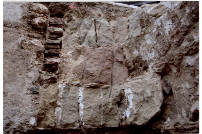
Lámina IV. Parte central de la muralla. Ladrillos y sillares (dispuestos a sogá y tizón).
