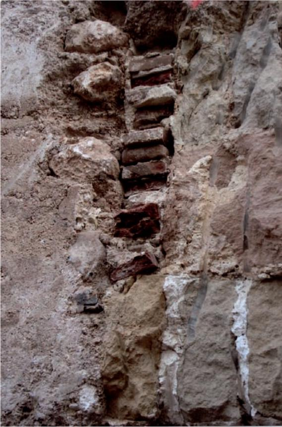
*Lámina V.* Ladrillos descansando sobre los sillares.
