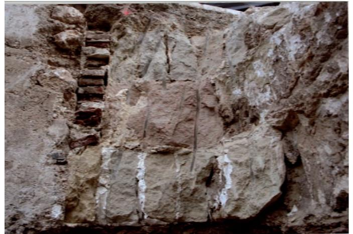
*Lámina IV.* Parte central de la muralla. Ladrillos y sillares (dispuestos a soga y tizón).
