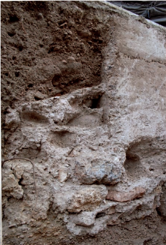
Lámina III. Detalle de la escarpa y muro de mortero.
