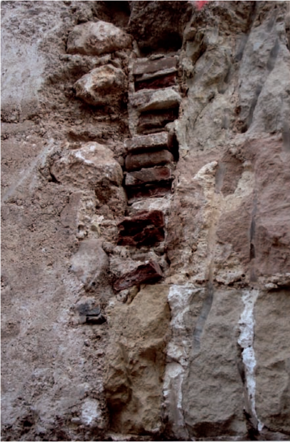
Lámina V. Ladrillos descansando sobre los sillares.
