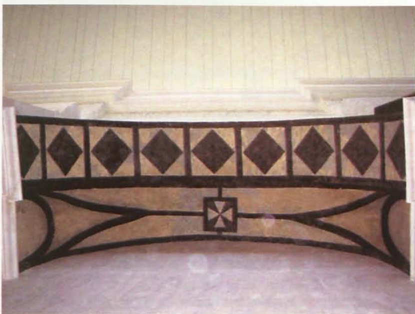
Intradós del arco 7. Estado anterior y posterior a la restauración
