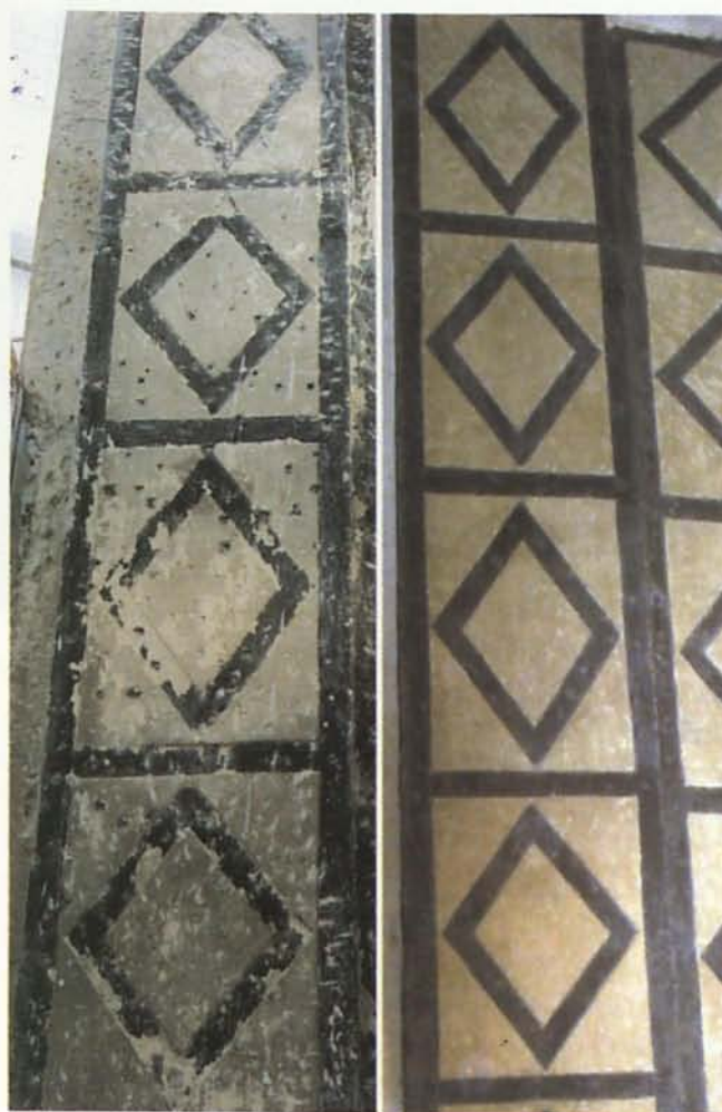
Lateral de arco 1, antes y después de la restauración
