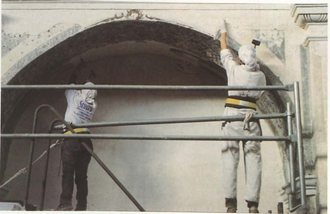
Eliminación de capas superpuestas
