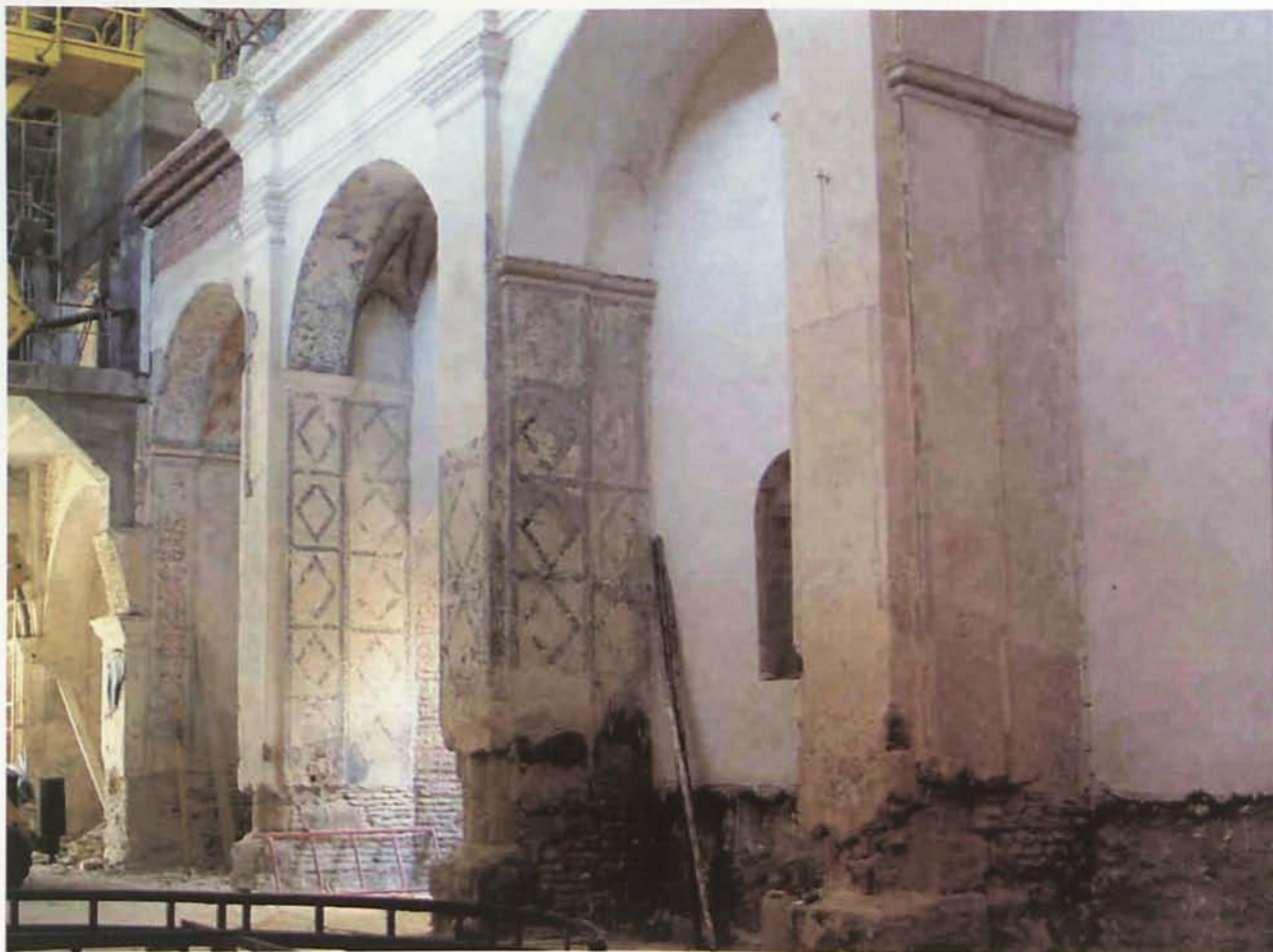
Los Mínimos durante los trabajos de rehabilitación
