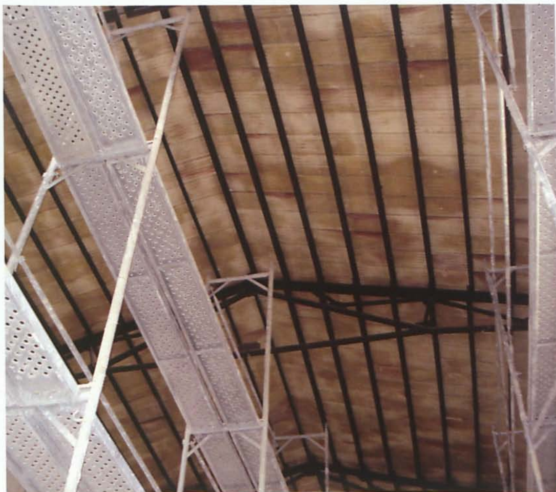
Estructura de cerchas y viguetas metálicas que daban forma al techo de la iglesia tras la remodelación de 1967-69
