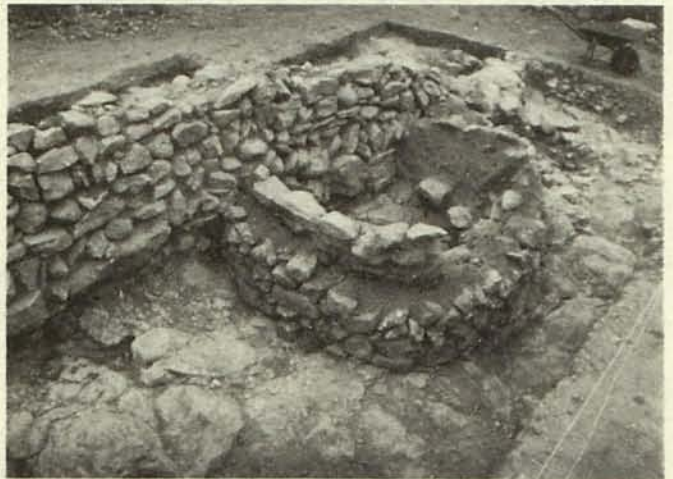
FOTO 19. Protección de la cimentación de la muralla.
