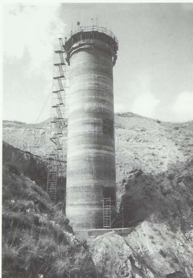
La torre de toma durante su construcción en julio de 1986. (Fondo fotográfico de la Presa de Cuevas del Almanzora / Cuenca Mediterránea Andaluza / Agencia Andaluza del Agua)
