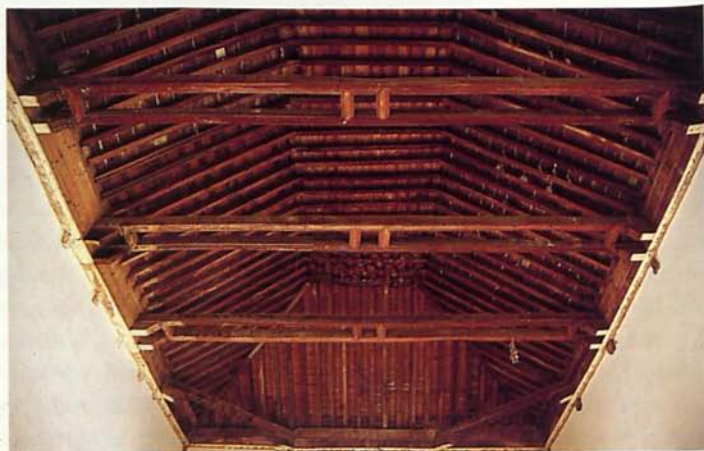
ALSODUX. Iglesia parroquial. Armadura de la nave.
