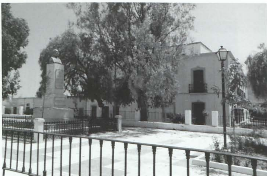
Vista del Paseo Nicolás Salmerón anterior a su destrucción. Año 2007.
