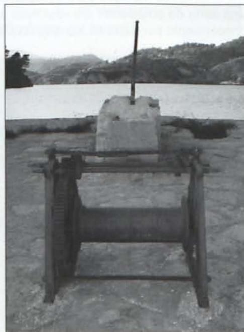
A la izquierda, vista del cuerpo de la presa de Tibi (1596). A la derecha detalle del sistema pescante con torno que se empleaba para la subida y bajada de una barrena de 18 m. de longitud y 500 kg. de peso utilizada en las "limpias naturales" del Pantano de Tibi<sup>6</sup>. Fotos del autor.
