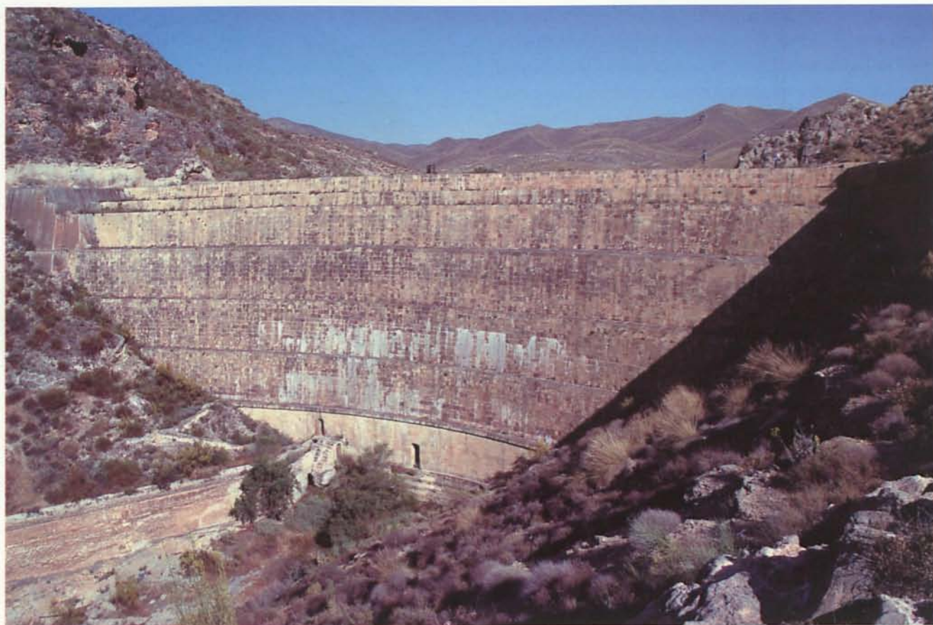
6. Jerónimo Ros proyectó una presa de gravedad con planta en arco, como las de Tibi o Almansa, y 31 metros de altura que se levantan sobre una cimentación en roca firme. En su construcción se empleó mampostería de cal en el interior y sillería caliza en las superficies exteriores. (Foto de José Guerrero)
