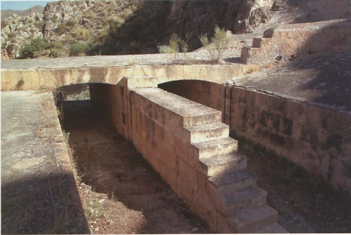
9. Los dos aliviaderos de superficie, situados en el estribo izquierdo, evacuarían aguas en el mometo de alcanzar su máxima capacidad. Se complementaban con un desagüe de fondo que permitía eliminar periódicamente los aterramientos. (Foto de José Guerrero)
