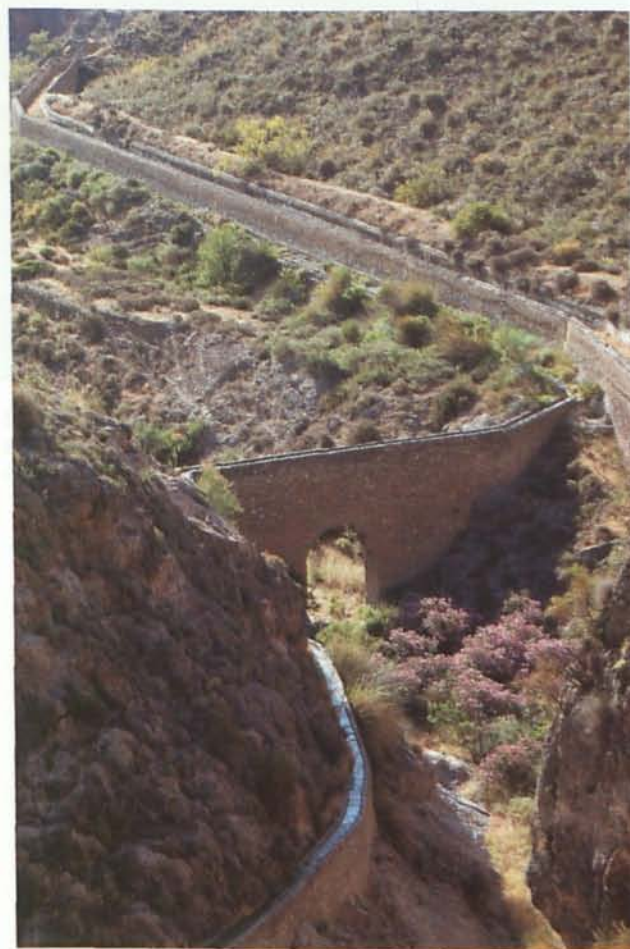
13 y 14. El Canal del Campo (arriba), que conducía las aguas del pantano hasta las sedientas tierras del llano de Níjar, debió superar numerosos obstáculos en su accidentado recorrido mediante la construcción de acueductos y galerías. Otro tanto ocurrió con la acequia (abajo) que llevaba las aguas a los hacendados de los Trisanes, compensándolos así por la pérdida de caudales que provocó la construcción del pantano. (Fotos de José Guerrero y Agustín Flores)
