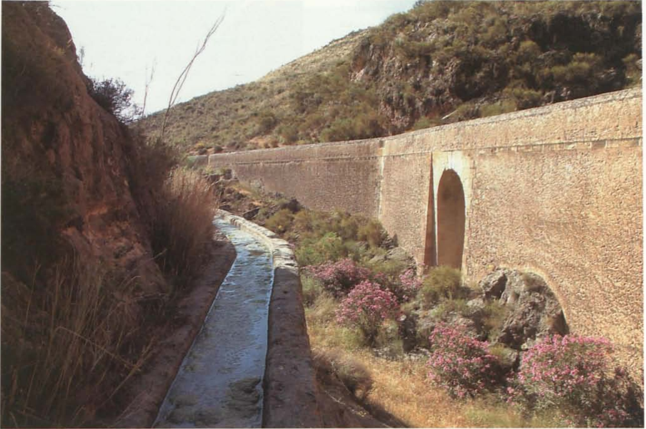
15. Perspectiva formada por el recorrido inicial, a ambos márgenes de la rambla, del Canal del Campo y la acequia de los hacendados de los Trisanes. Esta última cruzará un poco más adelante el cauce de la rambla mediante un acueducto, y desde ahí correrá en paralelo al primero. (Foto de José Guerrero)
