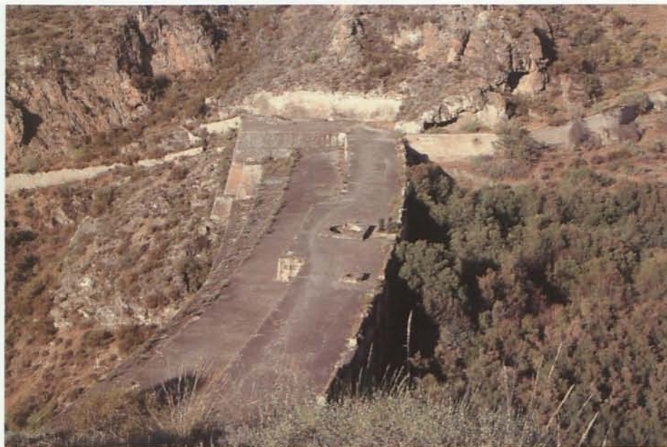
16. Con esta panorámica de la coronación de la presa, es fácil apreciar el nivel de colmatación del pantano. La maleza que invade su vaso nos puede servir de referencia para calcular los escasos cuatro metros que separan la superficie de lodos de la coronación. (Foto José Guerrero)
