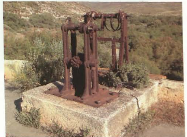
10 y 11. El pozo de toma (arriba) permitía dar salida, con destino a los riegos proyectados, al agua a diferentes niveles de llenado. Lo que queda del mecanismo (abajo) que accionaba las compuertas de los distintos niveles. (Fotos de Agustín Flores y José Guerrero)
