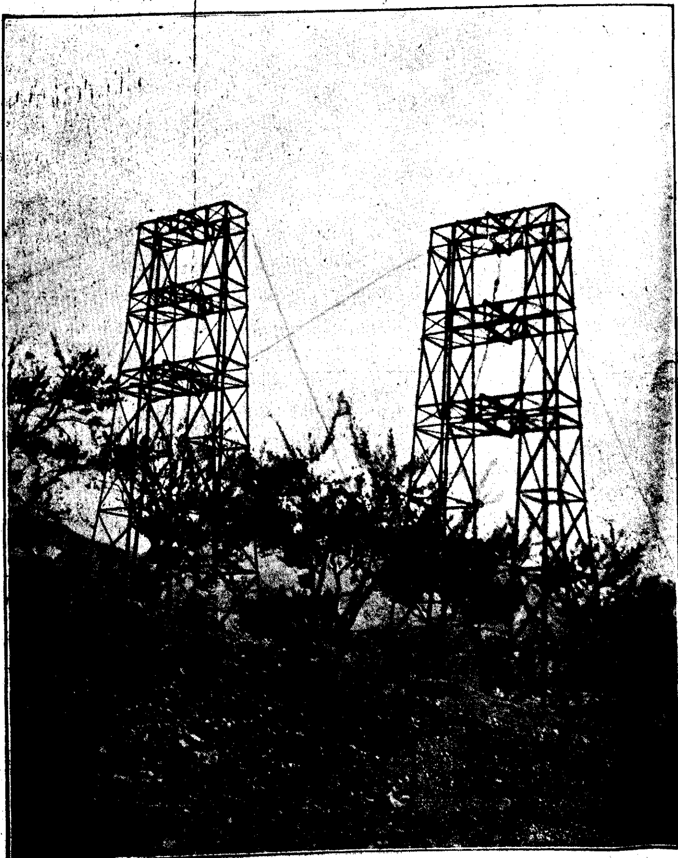
Doble columna para el cruce del río Guadalfeo, con vanos de 627 m., calculada para 7.000 kg. de tensión
