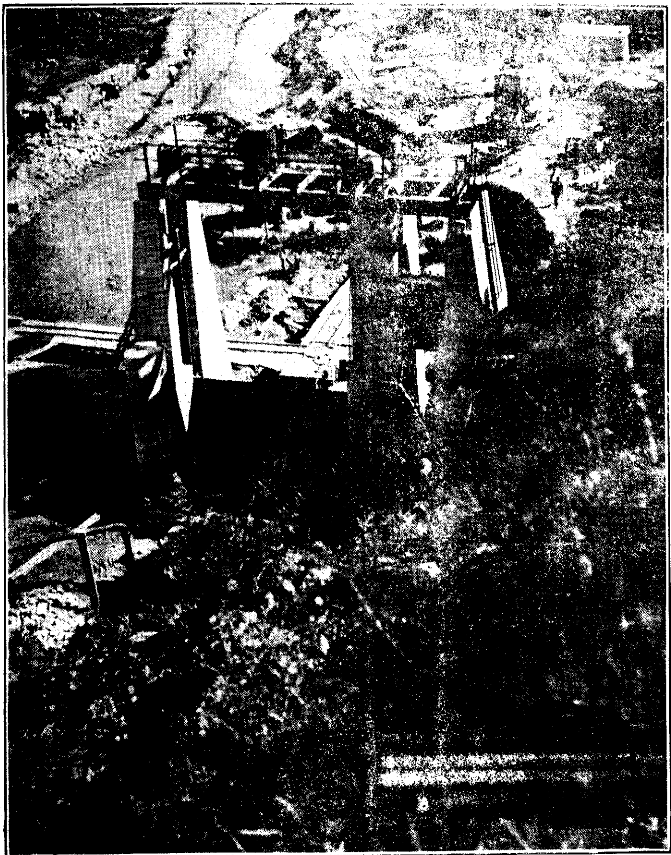
Compuerta de la presa del Salto de Izbor, vista aguas arriba.
