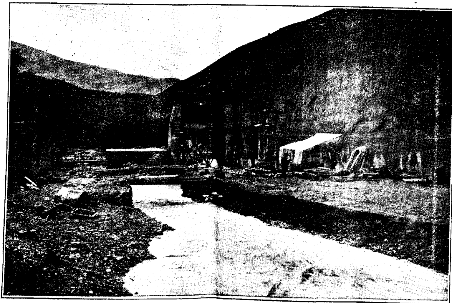
Desvío del río de Izbor durante la construcción de la presa.
