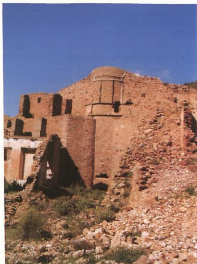
Foto 2. Planta de amalgamación a pie de mina de «María Josefa». Destaca el horno de cuba. (Foto G. Leal)
