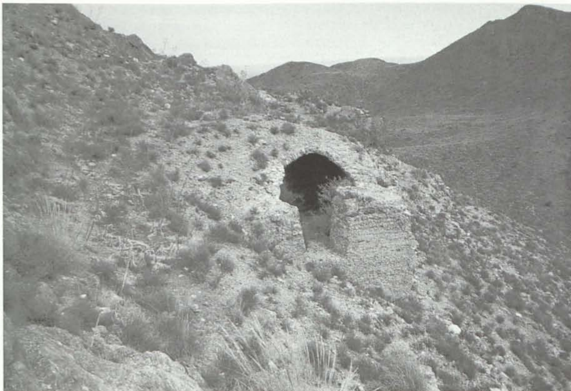
Aljibe del castillo de Lucainena de las Torres
