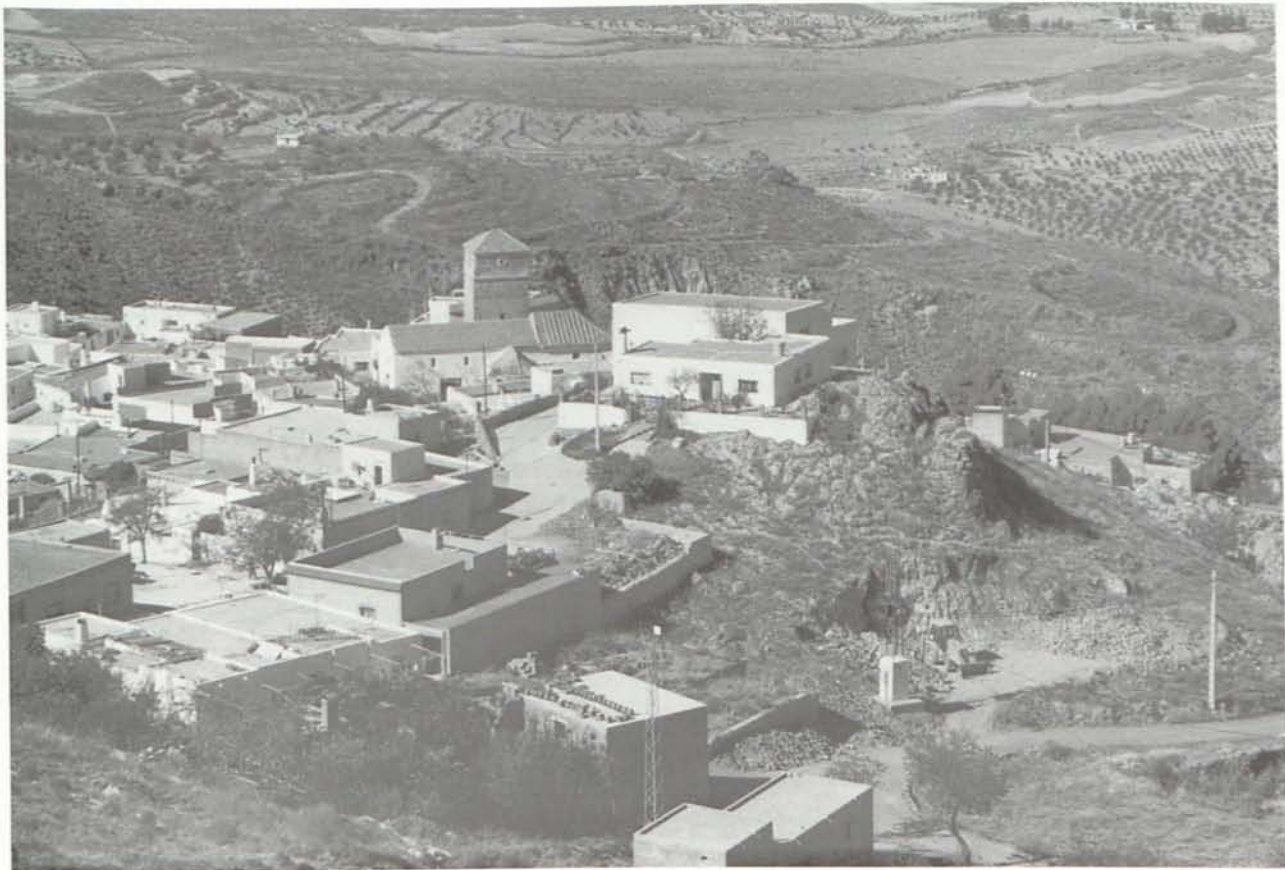
Castillo de Turrillas. A la derecha se aprecian los trabajos de desmonte en el cerro del castillo
