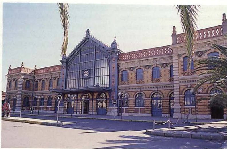
Fachada principal de la Estación de ferrocarril.
