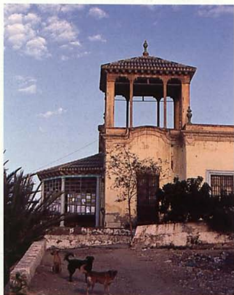
Detalle de la torre - mirador del chalet de La Molineta.
