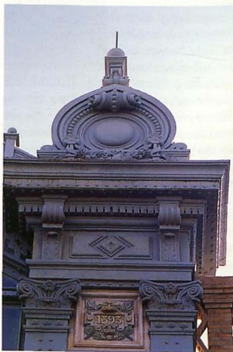
Detalle de una pilastra de hierro.
