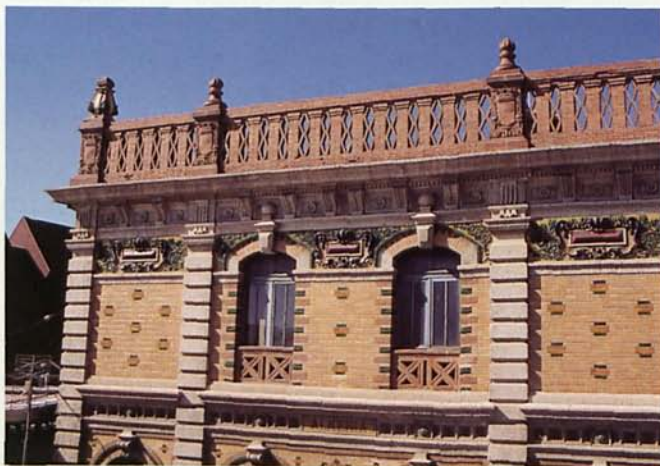
Fachada exterior de la Estación de ferrocarril.
