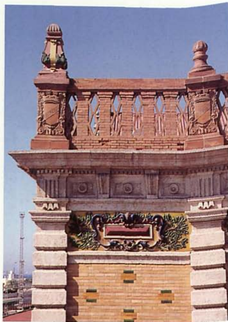
Detalle del coronamiento.
