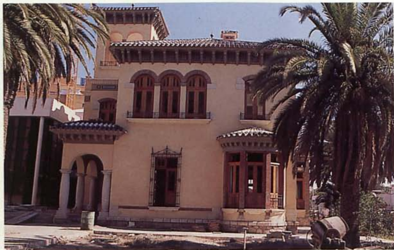
Antigua casa - chalet de D. José Batlles en Plaza de Barcelona.
