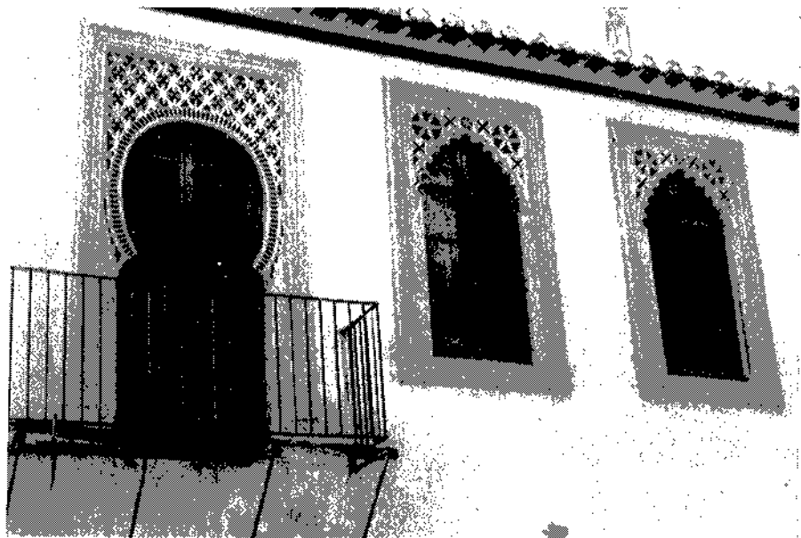
Cortijo de Montoro, aspecto de balcones y ventanas.
