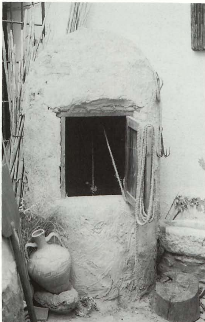
8. El pozo-aljibe, existente en el patio del Museo.
