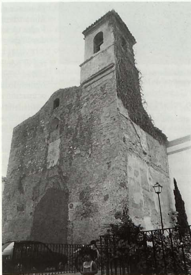
1. Iglesia del convento de Los Mínimos
