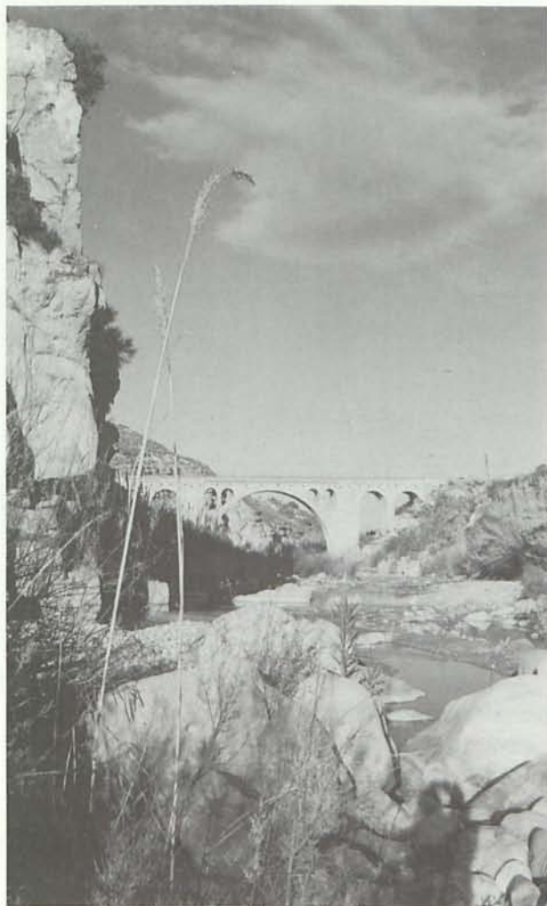
8. Río de Aguas. Puente Largo.
