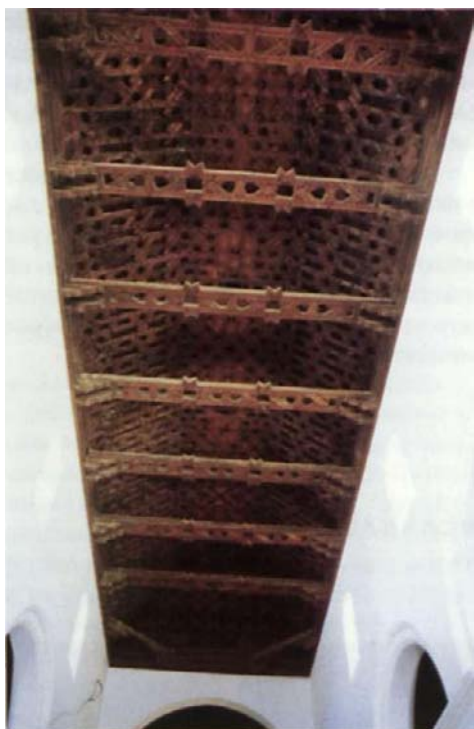
Armadura de limas moamares de ja cubierta
