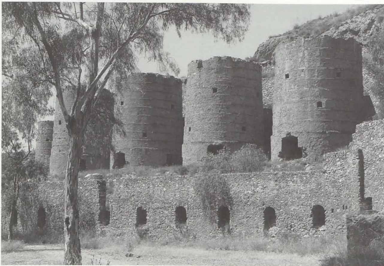
14. Viejos hornos de calcinación que formaban parte de las instalaciones mineras de la Mina de los Tres Pacos, en Sierra de Almagro. (Foto de Carlos Herguido)
