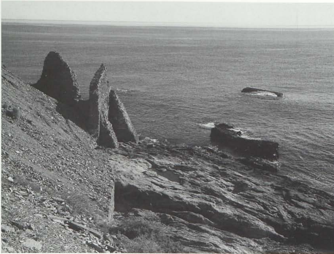
13. Restos del cargadero de Cala de las Conchas. Pueden apreciarse el estribo, a la izquierda, y la pilastra sobre la que descansaba la estructura metálica. (Foto de Carlos Herguido)
