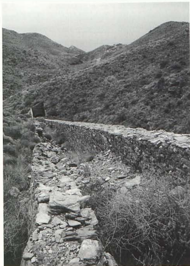
7. Detalle de la vertiginosa inclinación de esta infraestructura. (Foto de José Guerrero)
