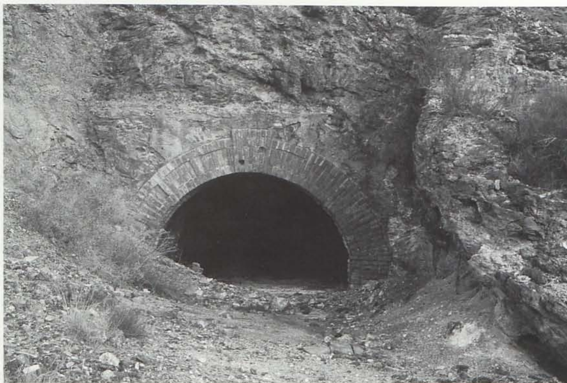
5. Con la perforación del túnel de San Agustín en 1907, de 320 metros de longitud, se vencía el principal escollo en la comunicación entre las vertientes de tierra y mar de Sierra Almagrera, conectando el ferrocarril de vía estrecha del Jaroso con el pronunciado plano inclinado que la Argentífera estaba construyendo. Así se muestra su salida al Jaroso en la actualidad, casi cegada por los desprendimientos.
