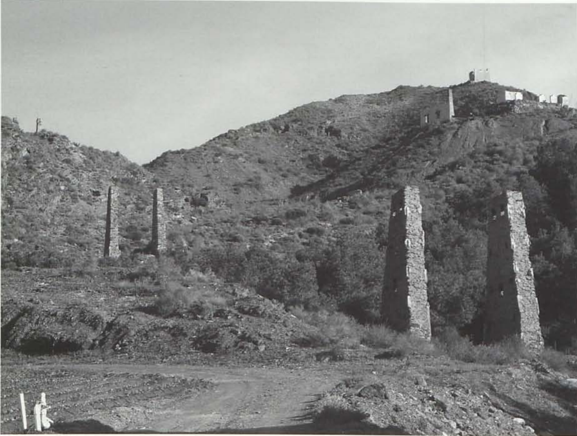
16. Tres de los caballetes de mampostería que, antes de cruzar Sierra Almagrera, sustentaban el cable aéreo que provenía de la Mina de los Tres Pacos en Sierra de Almagro. (Foto de Carlos Herguido)
