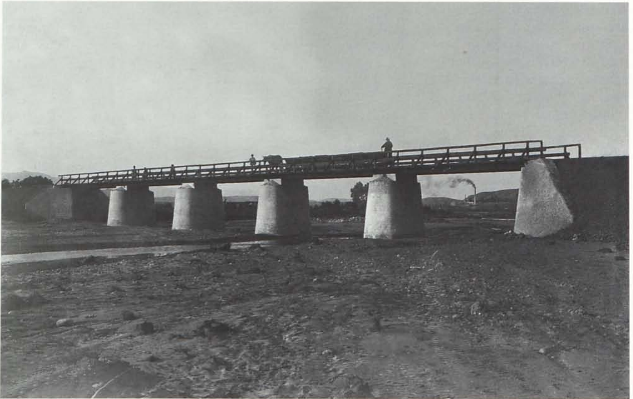
17. Fue el tercero de los puentes que, desde 1897, se levantaron en este punto de la línea férrea. Más sólido en su construcción que los anteriores, al emplear la mampostería en pilastras y estribos, se mantuvo en servicio hasta el desmantelamiento del ferrocarril. Hacia 1915. (Col. Pedro Perales Larios)
