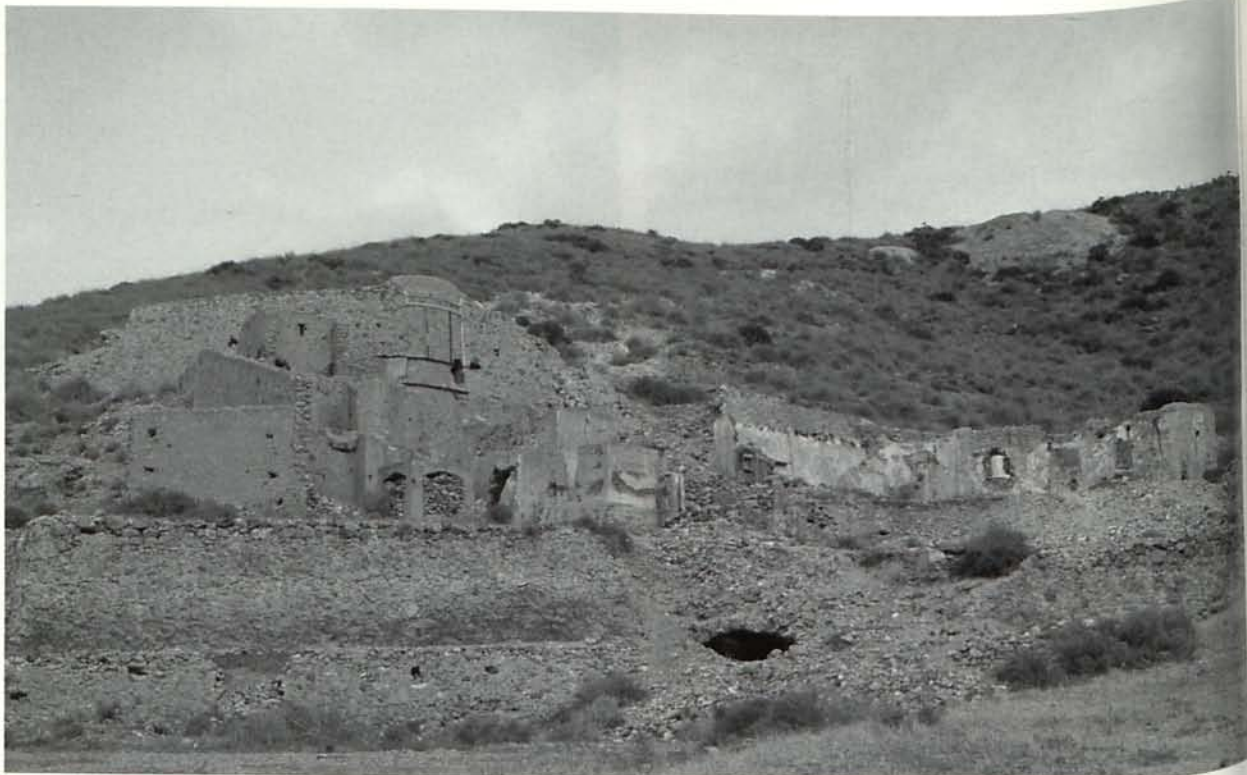
Figura 18. Instalación metalúrgica de amalgamación de la empresa "Minas Auríferas de Rodalquilar". Fue la primera instalación conocida, para la obtención de oro, construida en el Cabo de Gata. Se inauguró en 1925 y fracasó en 1926. (Fotografía de Francisco Hernández Ortiz).
