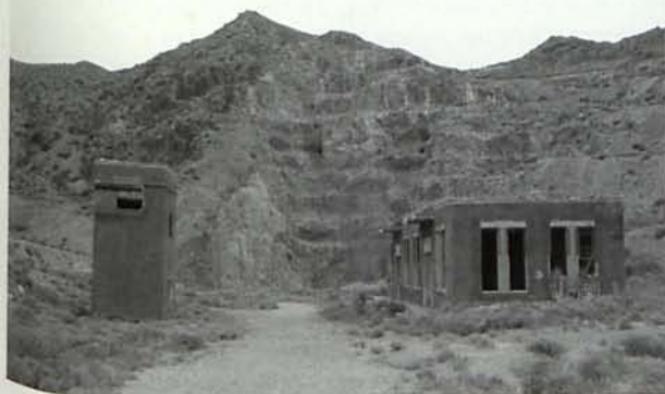
Figura 23. Instalaciones de la empresa "Adaro" en el cerro del Cinto: a la derecha está la casa de motores y la fragua, a la izquierda está el transformador. Al fondo se aprecia la cantera aurífera número 3, una de las mayores que se explotaron en la segunda mitad del siglo XX. (Fotografía de Francisco Hernández Ortiz).
