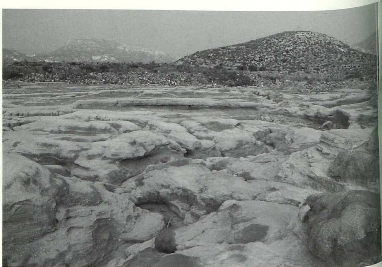
Figura 25. Balsa de los residuos del proceso metalúrgico de cianuración, en las inmediaciones de Rodalquilar. Acumula materiales producidos entre 1931 y 1966. (Fotografía de Francisco Hernández Ortiz).
