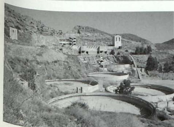
Figura 22. La Planta Denver en la actualidad. Es una instalación metalúrgica de cianuración de la empresa "Adaro", que se inauguró en 1956 y cerró en 1966. Más del 70% del oro producido en Rodalquilar ha salido de ella. (Fotografía de Francisco Hernández Ortiz).
