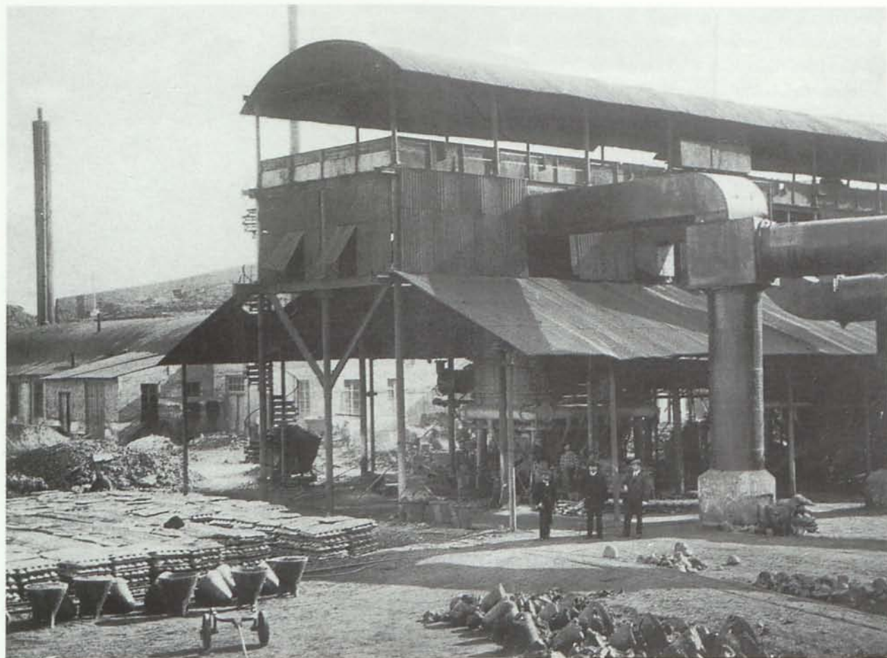
Instalaciones de la Fundición Santa Elisa. (Fotografía cortesía del Sr. H. Nonnast y M. Guillén Riquelme)
