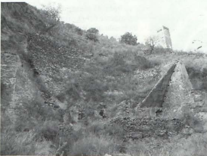
Tolva de la mina del pozo Esperanza.
