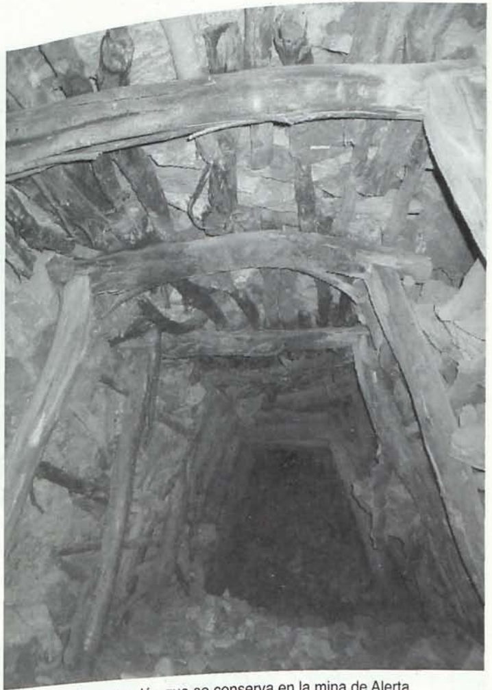
El trabajo de entibación que se conserva en la mina de Alerta .
