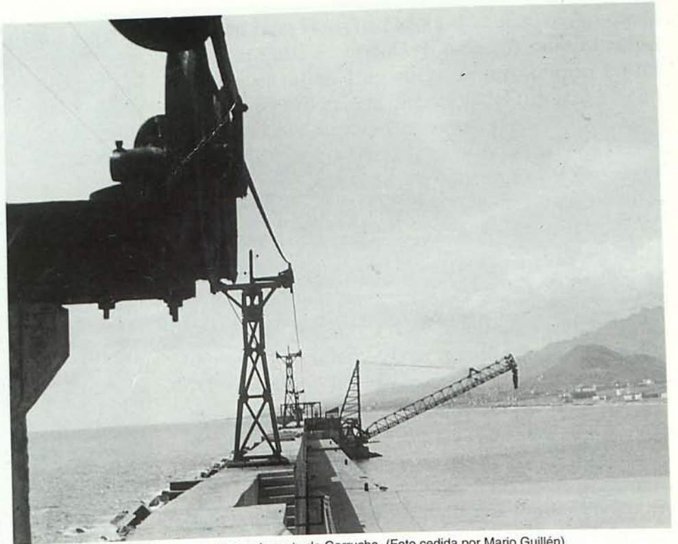
Año 1.956. Tramo final del monocable en el puerto de Garrucha. (Foto cedida por Mario Guillén).
