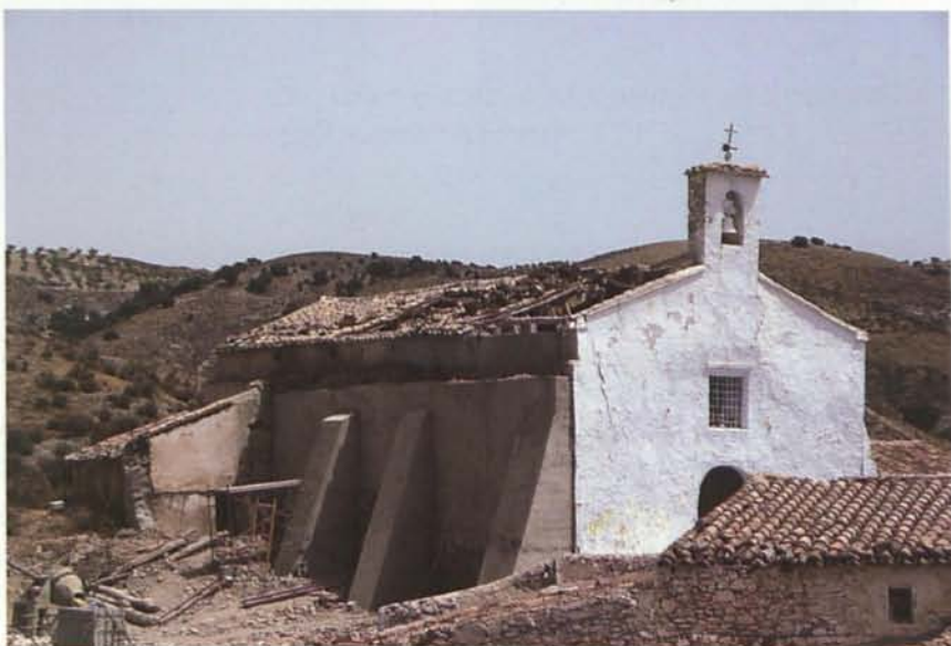
2 y 3. Arriba puede apreciarse el estado ruinoso que presentaba la ermita de Nuestra Señora de la Fuensanta antes del inicio de su rehabilitación; abajo, el templo en proceso de rehabilitación
