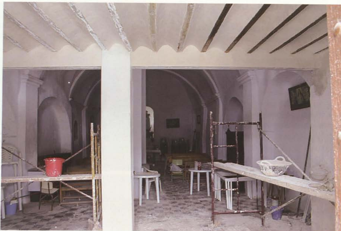
4. Interior de la ermita de Nuestra Señora de la Fuensanta en fase de rehabilitación
