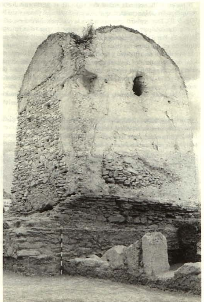
LAM. V. b. El mausoleo después de la excavación. Fachada Este y Sur.
