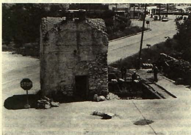
LAM. I. a. Mausoleo de Abla. Inicio de las excavaciones. Fachada Oeste.
