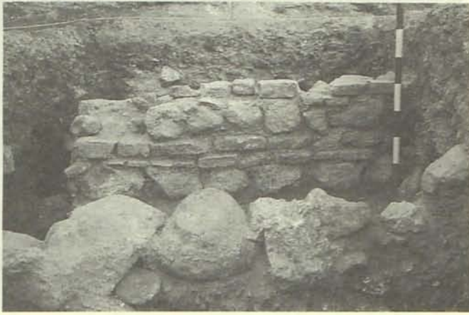
LAMINA VI. Detalle del aparejo constructivo nazarí en C/Narváez.
