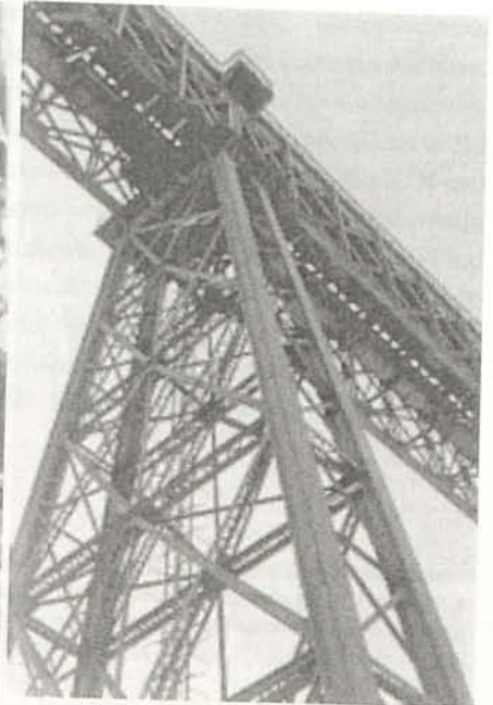
Fig. 3. Puente de Guadahortuna. Pilar de hierro.
