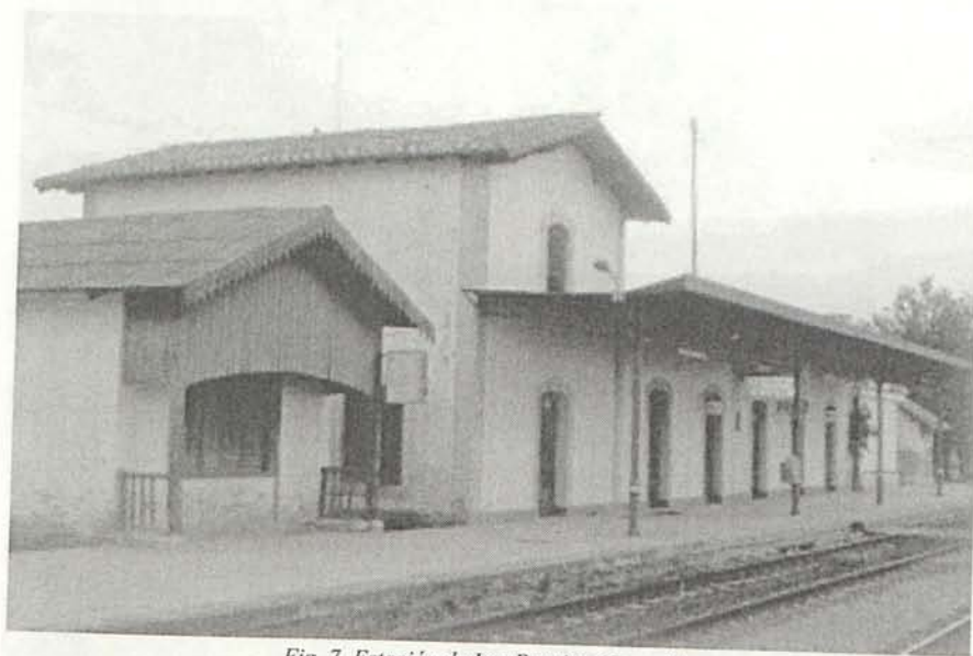
Fig. 7. Estación de Los Propios (Cazorla).
