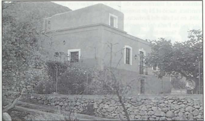
Cortijo de "Relampaguito" en el paraje frente al Balneario de Alhama.
