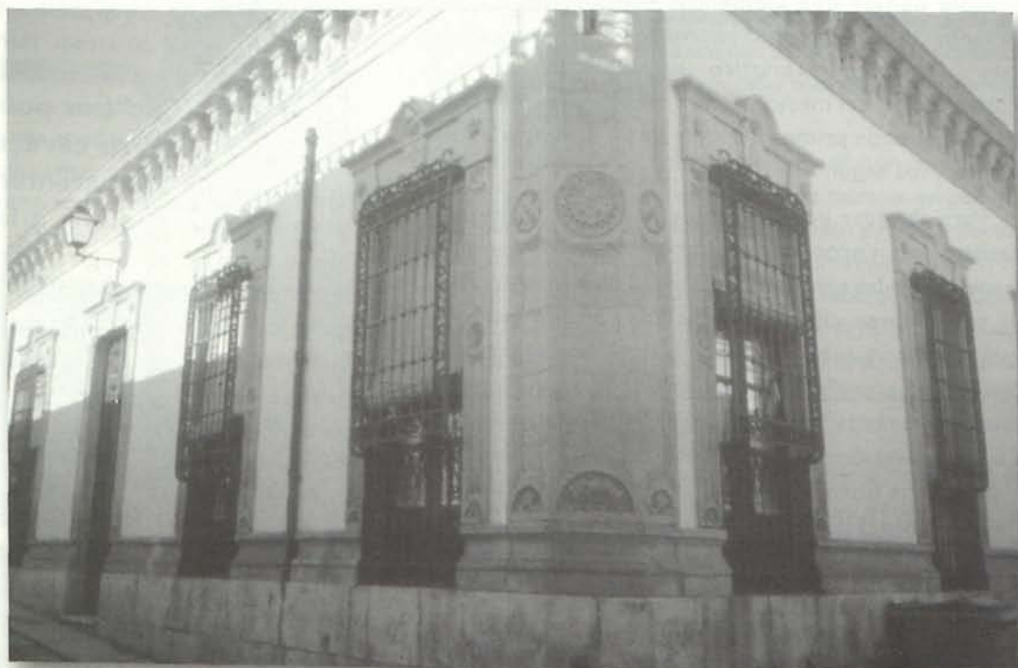
Fachada de una de las casas mejor rehabilitadas de Alhama, ubicada en la calle San Nicolás, esquina con calle Barcelona
