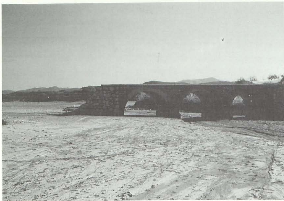
1. Estado en que quedó el Puente del Peral sobre la Carretera Comarcal 323.
