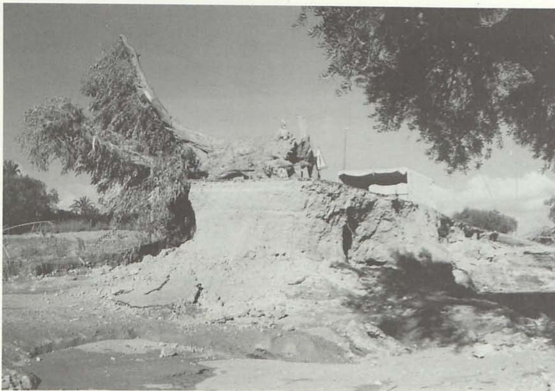
2. Un maquinista de gran pericia no hubiese colocado el olivo tan bien sobre el terraplén que hizo el agua al cortar la carretera 323.
