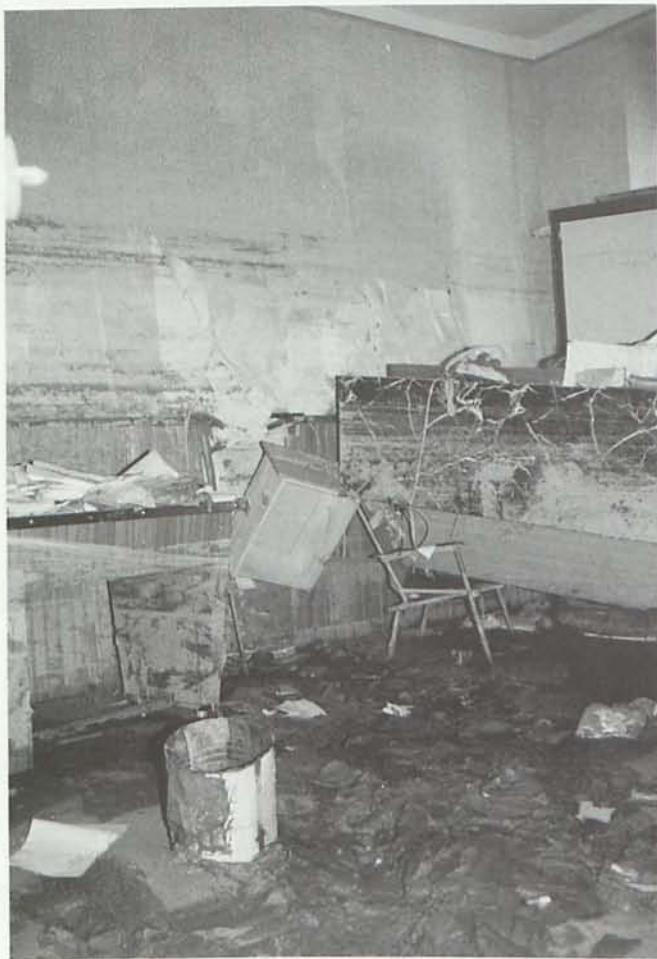
9. Así quedó la oficina de la Caja Rural.
