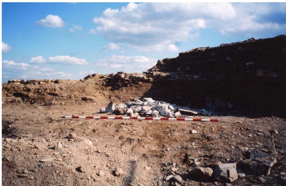
Lám. IV Explanación de la parte superior de la torre y eliminación de construcciones recientes.
