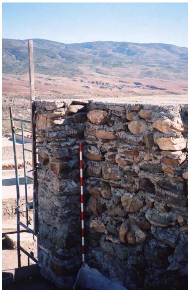
Lám. VIII Muro de contención junto a escalera de acceso revestido de mampuesto.
