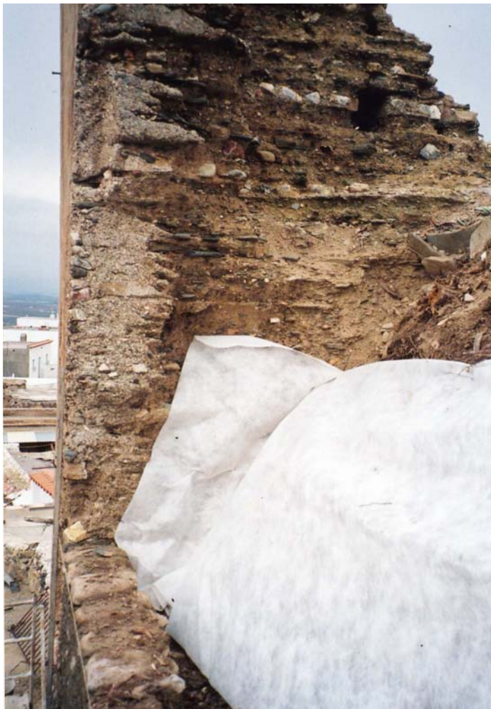
Lám. VI Geotextil empleado para diferenciar el relleno original de los nuevos aportes.
