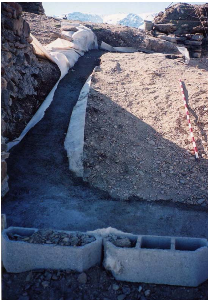
Lám. III Zapatas para la construcción de la escalera de acceso a la parte superior de la torre y muro de contención.
