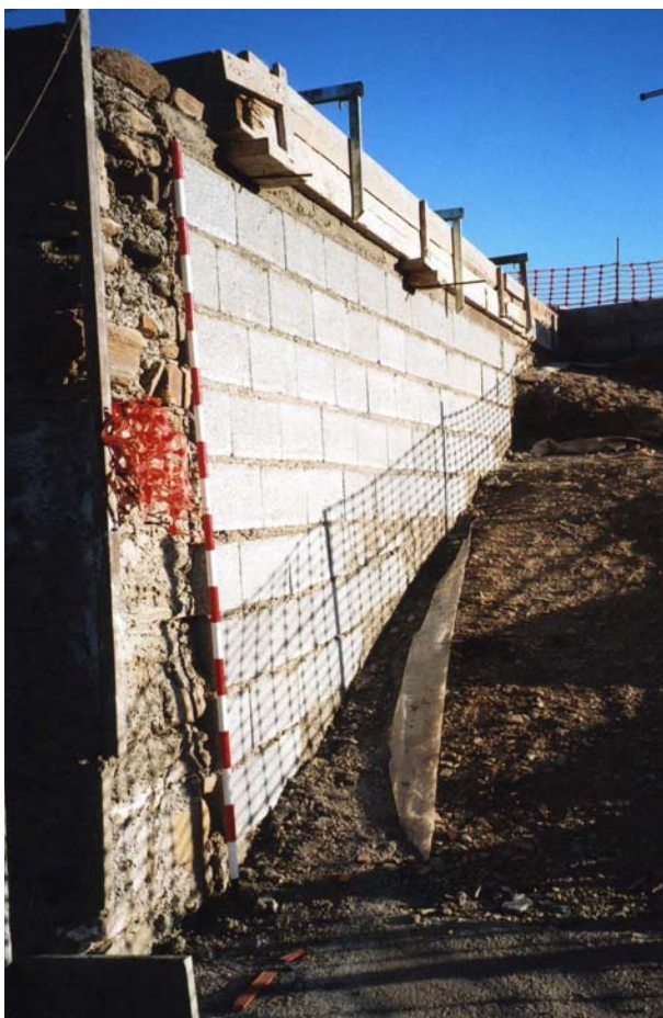
Lám. VII Muro de contención junto a escalera de acceso.
