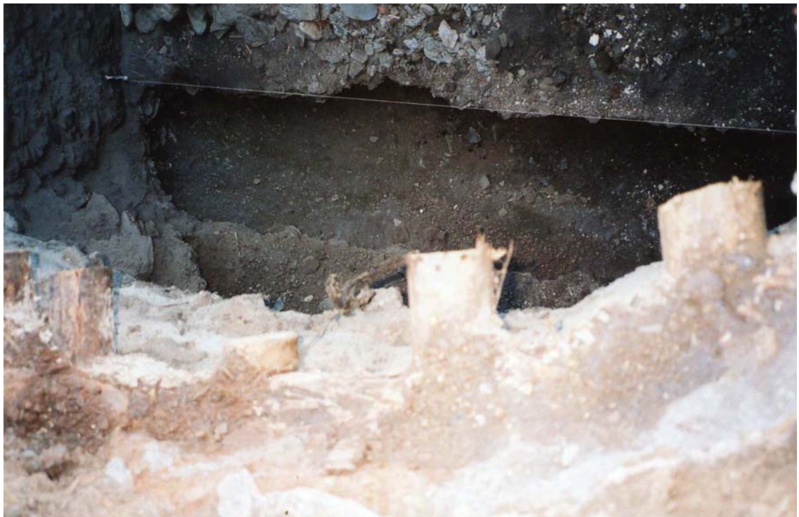
Lám. II Zanja para la cimentación del muro de la cara norte.
