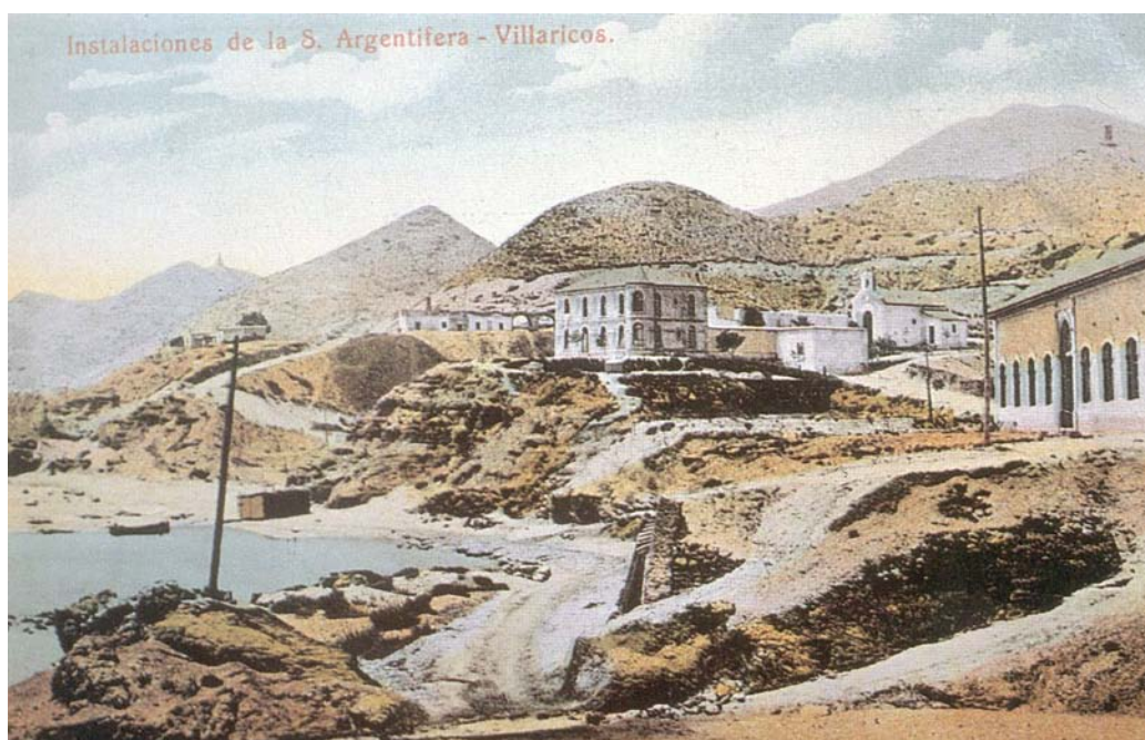
Lámina II. Instalaciones de la Sociedad Argentífera (1909-1910). La imagen pertenece a la colección de Federico de Blain Becerra, extraída de la obra Memoria visual del siglo XX. La tarjeta postal ilustrada en Cuevas del Almanzora .
